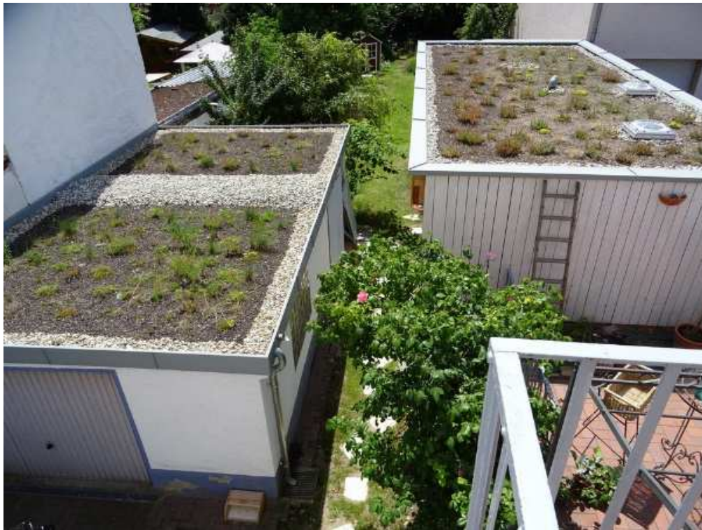
Abb. 3: Neu geschaffene Flachdächer mit Trockenrasen-Begrünung
